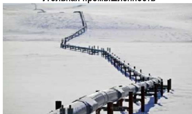
Нефте- и газопроводы
