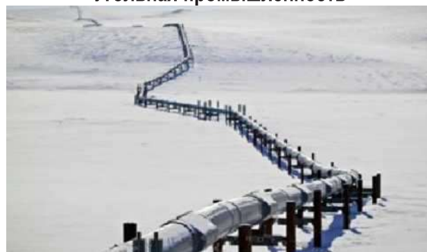
Нефте- и газопроводы
